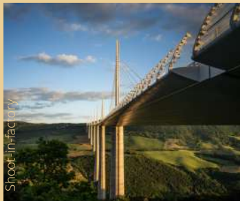
Viaduc de Millau
