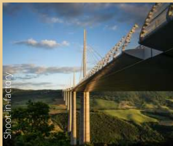
Viaduc de Millau
