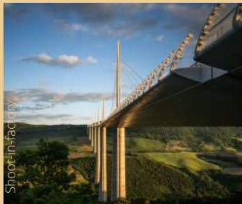
Viaduc de Millau
