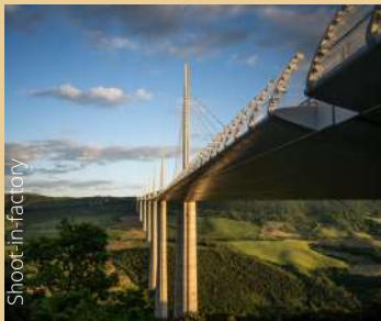
Viaduc de Millau
